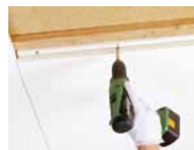
Instalace Master F pomocí šroubů
