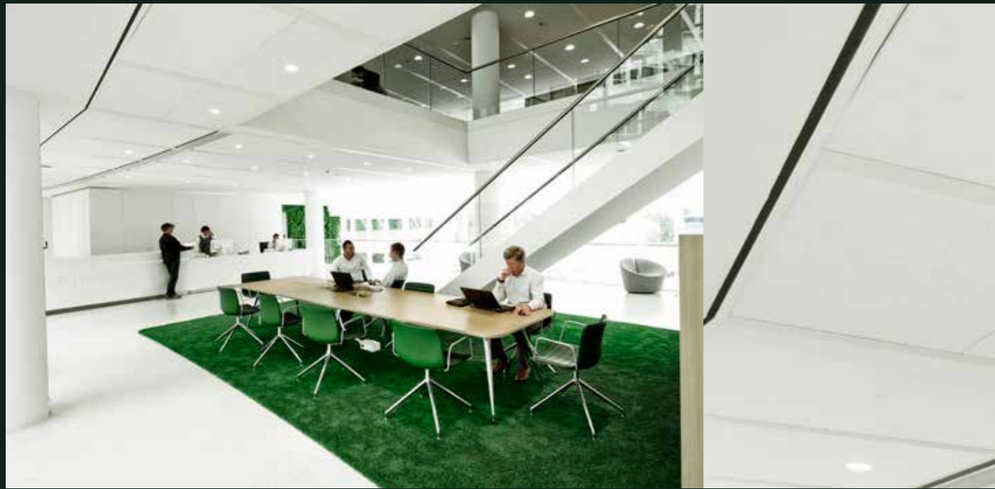
FOCUS D/A Pro chodby a řešení Bandraster. Dlouhé panely se skrytým rastrovým systémem.
