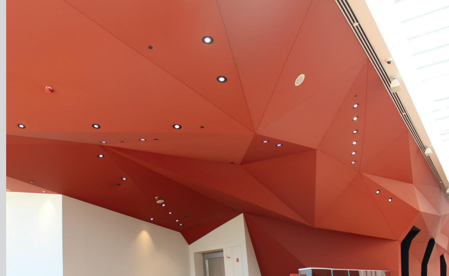
Nutzen Sie Ecophon Clipso vollflächig über die ganze Decke. Die Ursprungs- bzw. Rohdecke wird somit komplett verdeckt. Die nun sichtbare Oberfläche besteht aus einem strukturierten und beschichteten Hochleistungsgewebe, das eine hohe Widerstandsfähigkeit aufweist.
