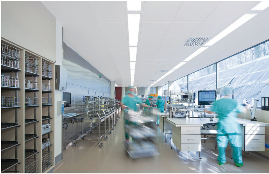
Bild 5 Zentralsterilisation im Ortenau Klinikum Lahr Ettenheim, ausgestattet mit Akustikdeckensystem Ecophon Hygiene Meditec E.
