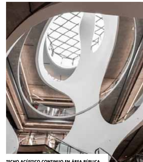
TECHO ACÚSTICO CONTINUO EN ÁREA PÚBLICA
