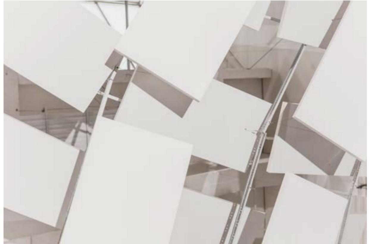
”Si se instalan correctamente los absorbentes suspendidos, se aprovecha tanto la parte superior como la inferior del panel para la absorción acústica, y se duplica el efecto”.
