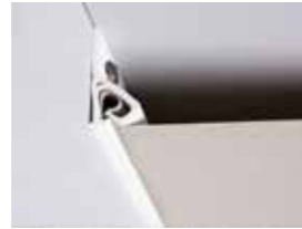
Techo Clipso instalado con perfil PCW
