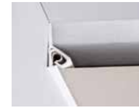
Techo Clipso instalado con perfil PVC y absorbente.
