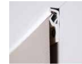
Clipso seinäasennus PCC-profililla.
