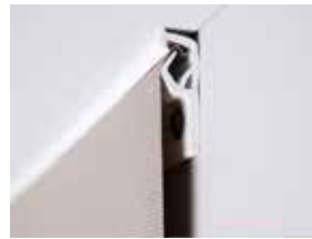
Clipso seinäasennus PCC-profiililla.
