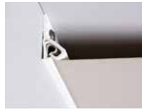
Clipso alakattoasennus PCW-profiililla.
