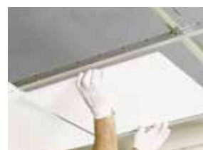
I pannelli sono facilmente smontabili
