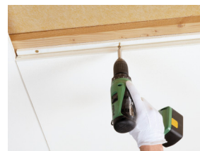
O Master F é instalado por fixação com parafusos
