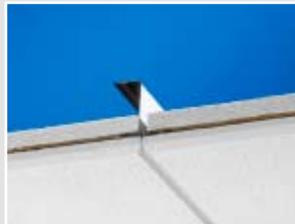
Sezione del sistema Hygiene Protec C con Connect Z-profile
