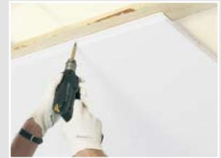
Focus F viene installato con viti di fissaggio
